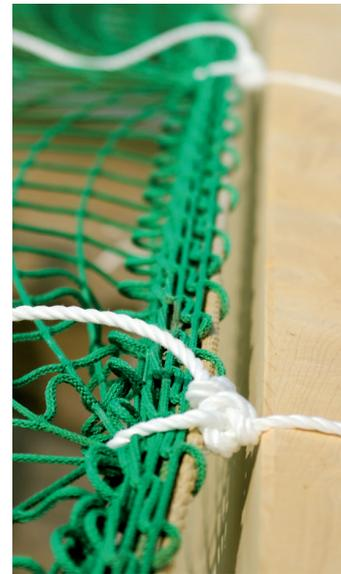
Maßgeblich für die Netzaufhängung ist die EN 1263-1 in Verbindung mit der DGUV-Regel 101-011. Hiernach sind Auffangnetze im Höchstabstand von 2,50 m an tragfähigen Aufhängepunkten zu befestigen. Jeder Aufhängepunkt muss für eine charakteristische Last von mindestens 6 kN bemessen werden. Die Aufhängung erfolgt mit Aufhängeseilen, Sicherheitskarabinerhaken, Netzkauschenschlaufen oder Schutznetz-Kauschen.
